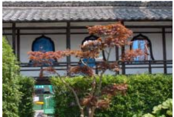
図34 渡り廊下 西面
