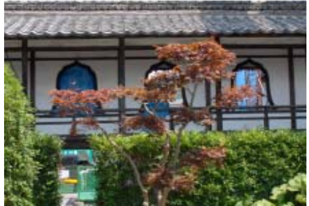
図 34 渡り廊下 西面
