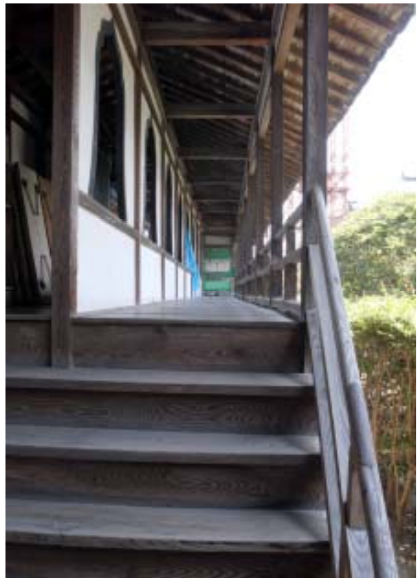
図35 渡り廊下 内部
