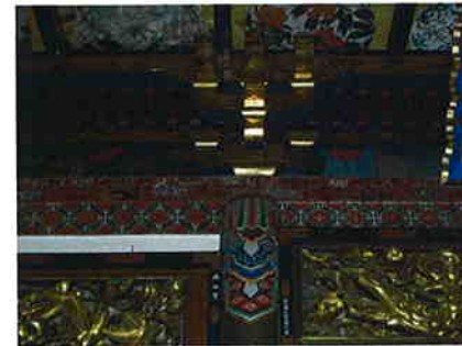
内外陣境丸柱柱頭部
