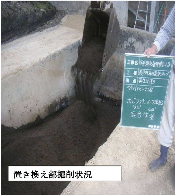
置き換え緑化基材の混合状況
