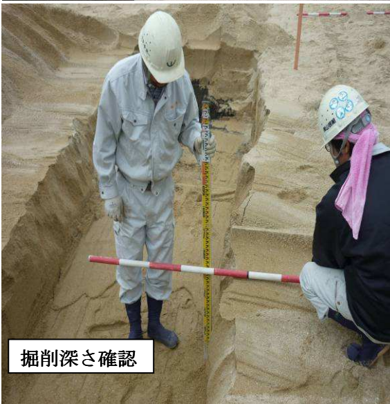
置き換え部掘削状況
