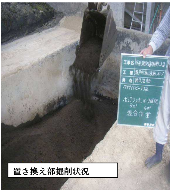
置き換え緑化基材の混合状況
