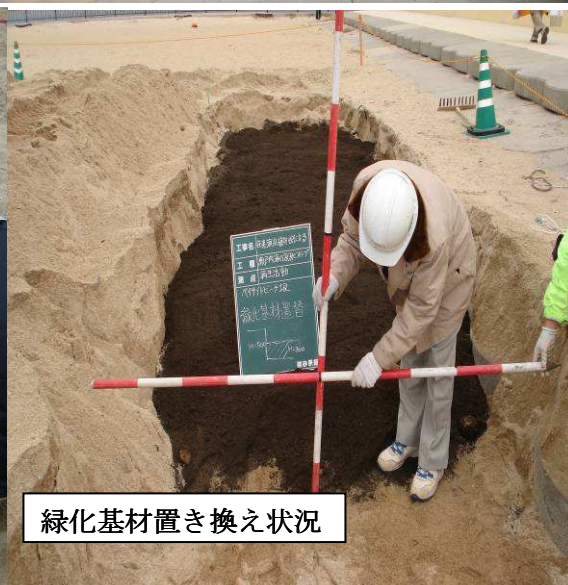
置き換え緑化基材の混合状況
